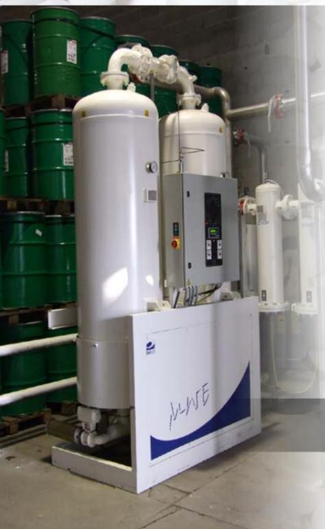
Le sécheur par adsorption est la technologie la plus employée pour obtenir des points de rosée très bas (de l'ordre de  $-40^{\circ}\text{C}$  sous pression).
