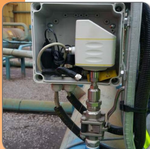
Débitmètre PITO installé en extérieur avec protection par coffret IP 66
