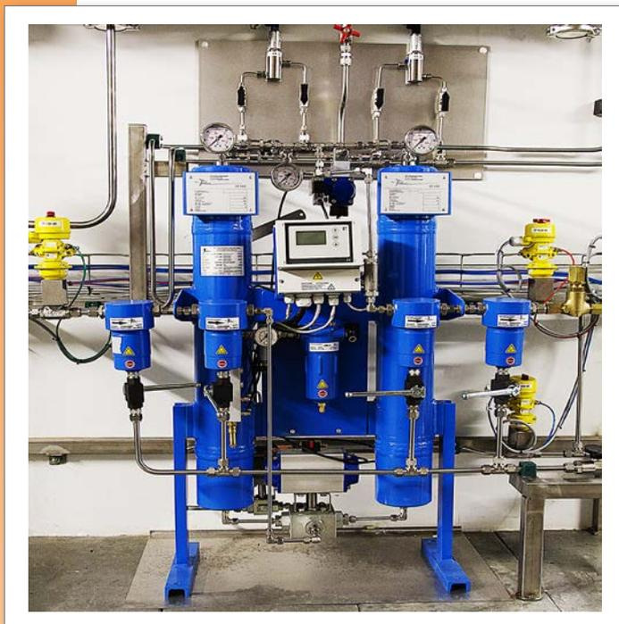
Nous l'évoquions dans notre édition de septembre 2015, voici les premières photos de l'installation de **séchage d'hélium** à haute pression délivrant un point de rosée sous pression de -70°C.
